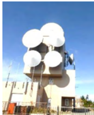
【レーダー雨量観測所】
