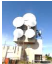
【レーダー雨量観測所】
