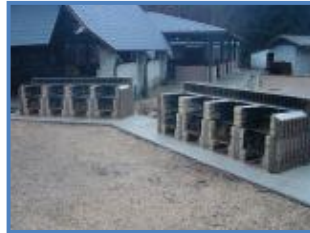
固定式かまど(外): 屋根のない場所に16基のかまど を設置しています。
