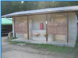
トイレ: 使用された後は、清掃を お願いします。
